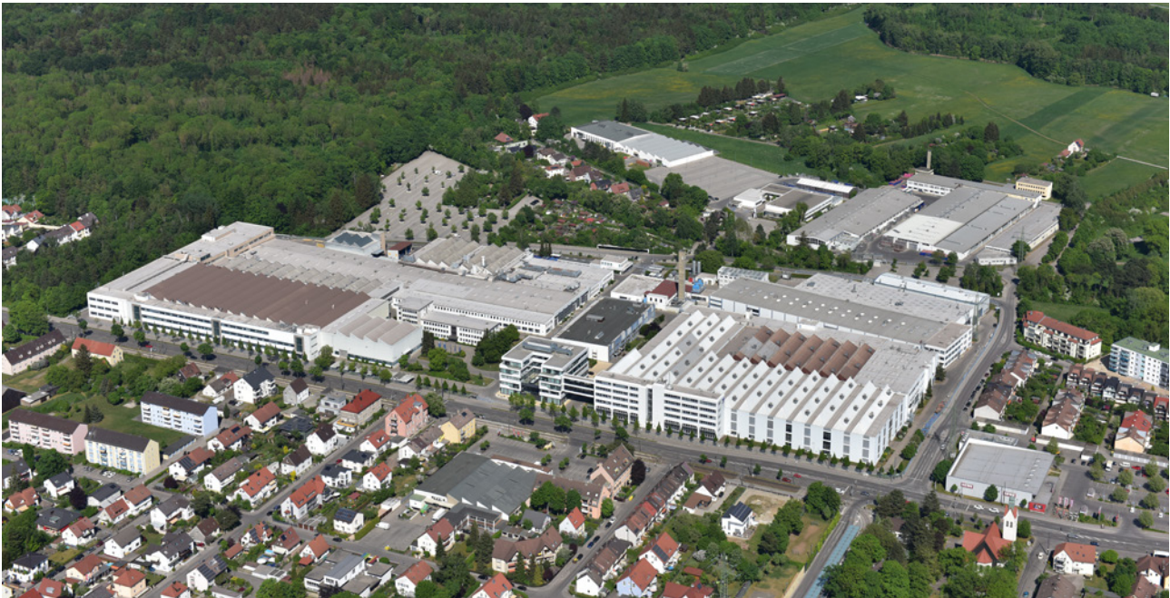
Blick über Werk IV aus Richtung Werk I
